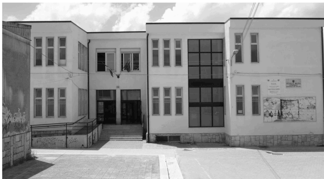
Fig. C-1 Foto prospetto NE.
