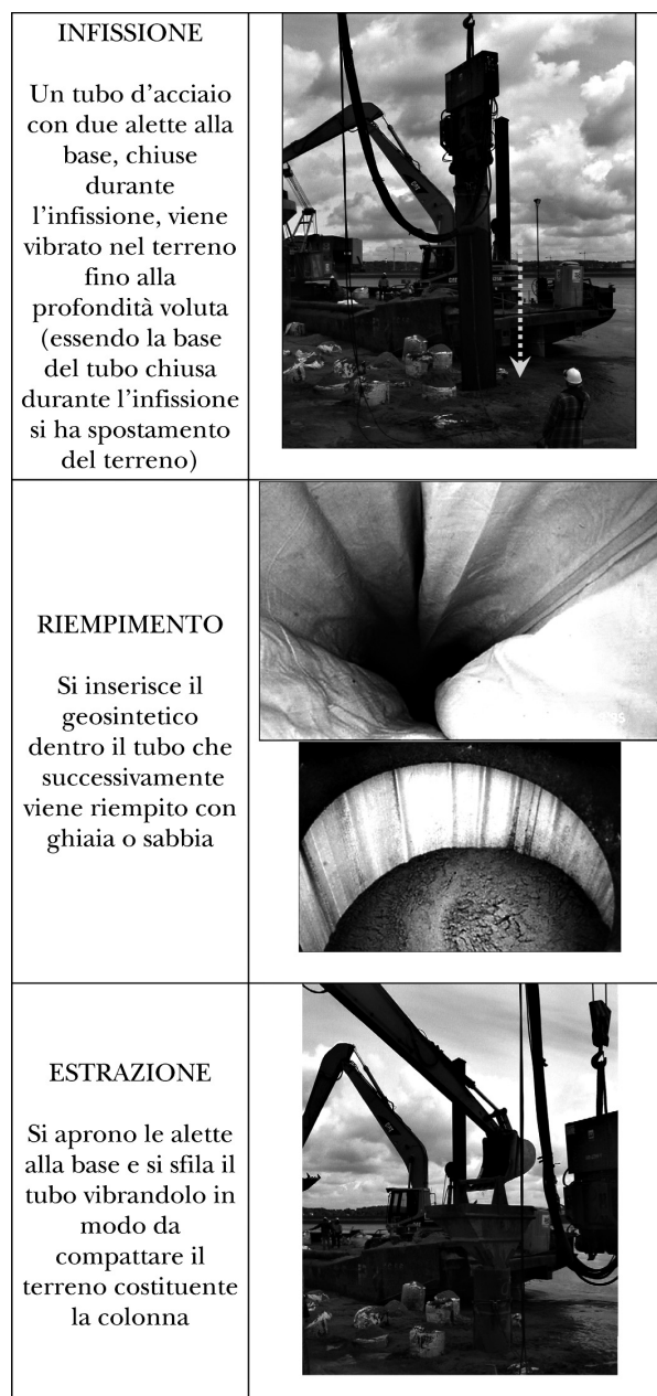
Fig. 31 – Colonne di sabbia o ghiaia rinforzate con geosintetici (GEC): metodo per spostamento (Foto Huesker).
